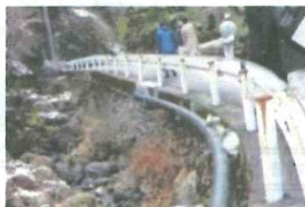
クイック配管 (露出配管)
