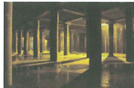
貯留施設(福岡市)
