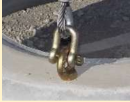
斜壁天端：アイボルト
